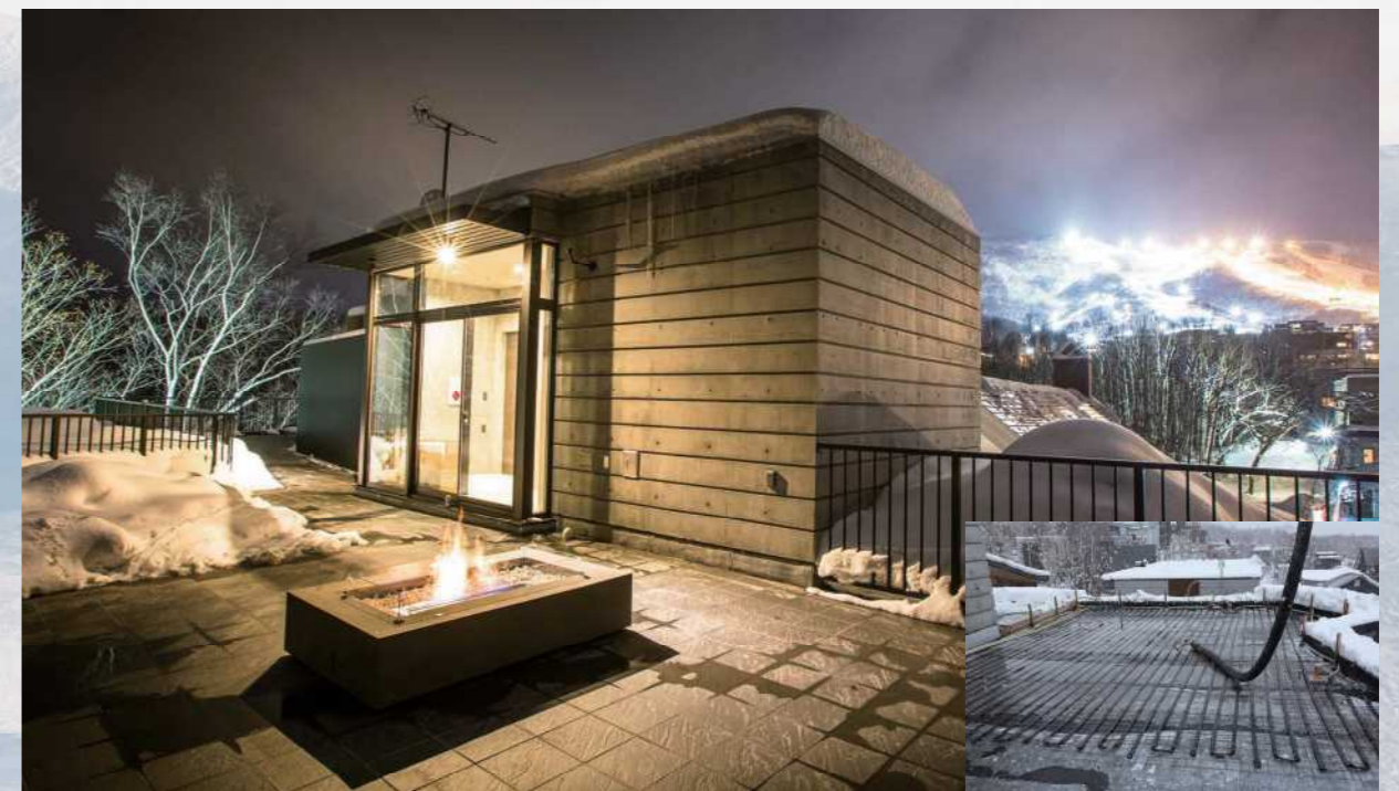
ニセコスキー場 施設屋上（施工例）
