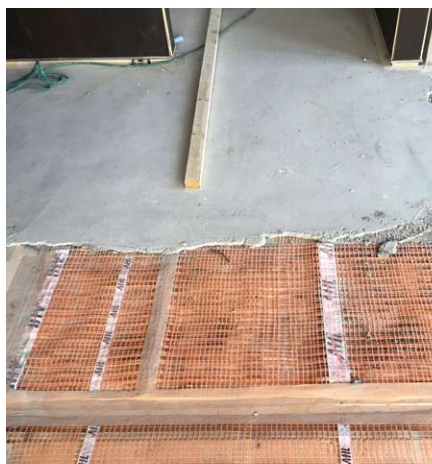
モルタル塗タイル仕上げ
